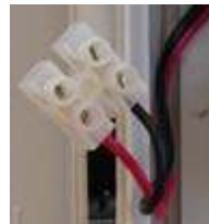
Рисунок 12. Клеммы для подключения замка к блоку питания
